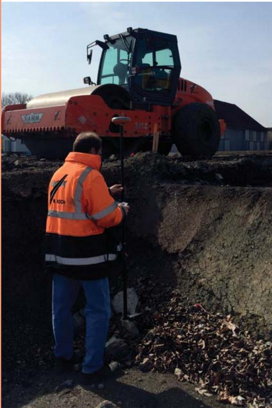
Volumenberechnung einer Baugrube
