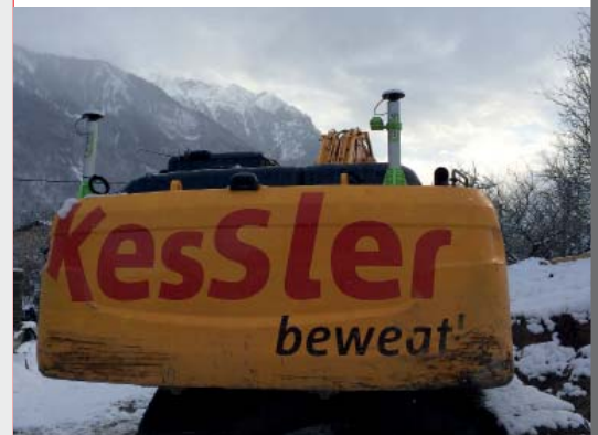
Einrichten eines Baggers mit GNSS-Empfängern
