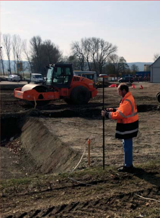
Abstecken von Punkten und Achsen im Tiefbau
