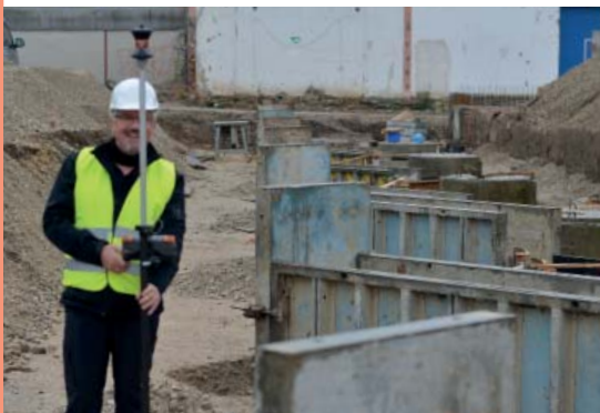
Messung mit Rundum-Prisma auf der Baustelle
