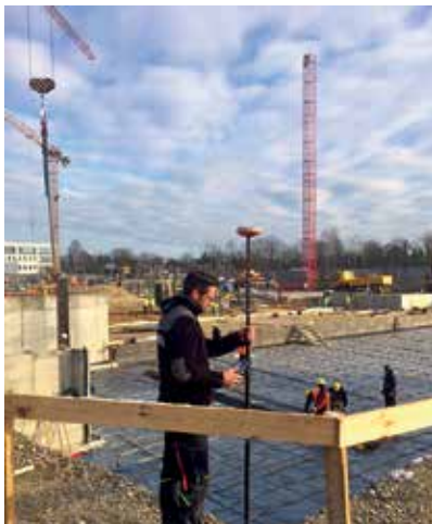
Abstecken von Punkten und Achsen im Tiefbau
