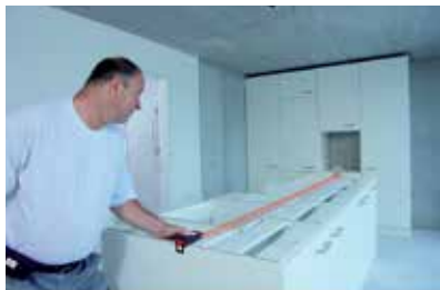
Vermessung im Innenbereich
