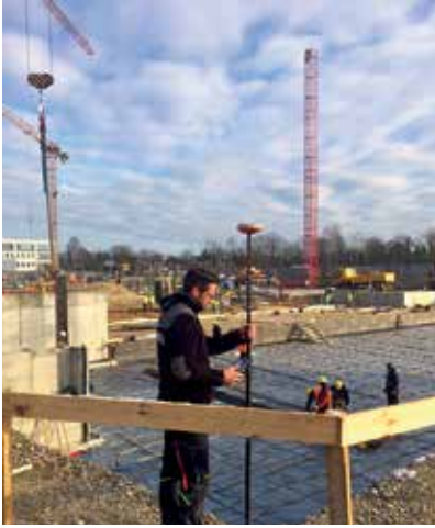
Abstecken von Punkten und Achsen im Tiefbau
