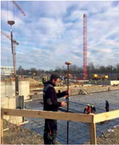
Abstecken von Punkten und Achsen im Tiefbau
