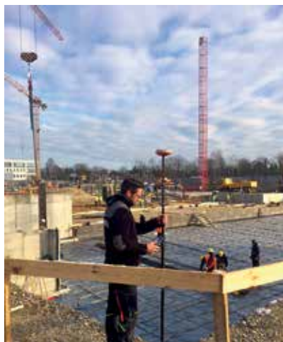
Abstecken von Punkten und Achsen im Tiefbau
