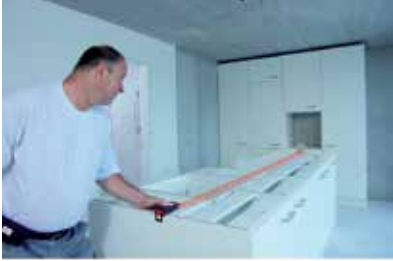
Vermessung im Innenbereich
