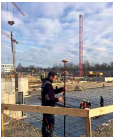
Abstecken von Punkten und Achsen im Tiefbau
