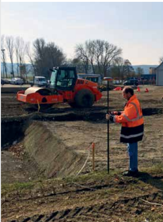
Abstecken von Punkten und Achsen im Tiefbau
