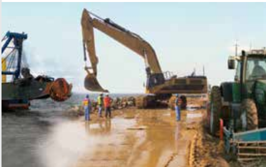
Maschinensteuerung mit dem AsteRx-U
