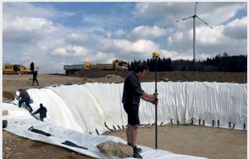
Volumenaufnahme einer Baugrube mit der Zenith35 Pro
