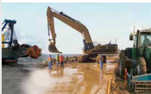
Maschinensteuerung mit dem AsteRx-U
