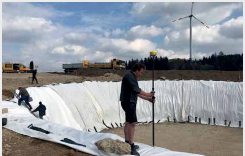
Volumenaufnahme einer Baugrube mit der Zenith35 Pro
