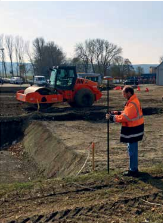
Abstecken von Punkten und Achsen im Tiefbau
