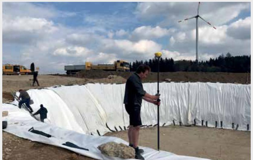
Volumenaufnahme einer Baugrube mit der Zenith35 Pro
