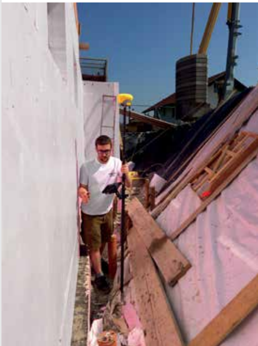
Einsatz einer Zenith35 Pro TAG sehr nahe an der Hauswand
