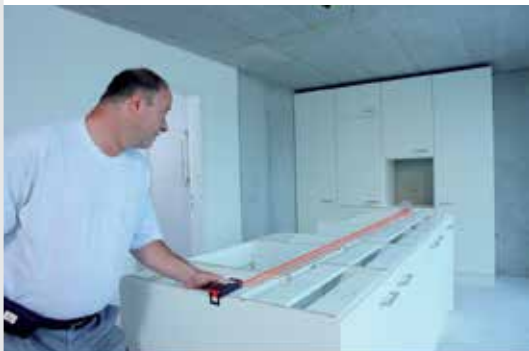
Vermessung im Innenbereich
