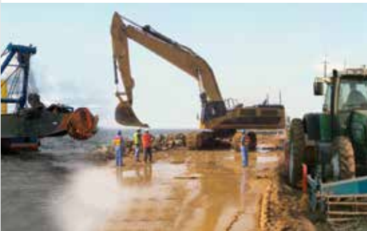
Maschinensteuerung mit dem AsterX-U
