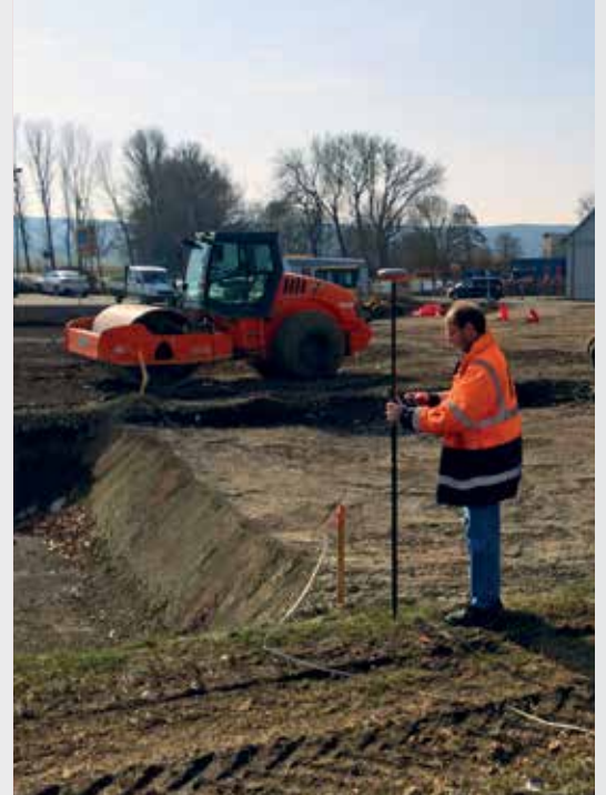
Abstecken von Punkten und Achsen im Tiefbau
