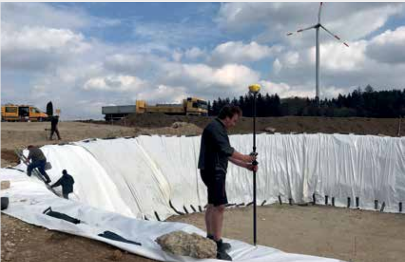
Volumenaufnahme einer Baugrube mit der Zenith35 Pro
