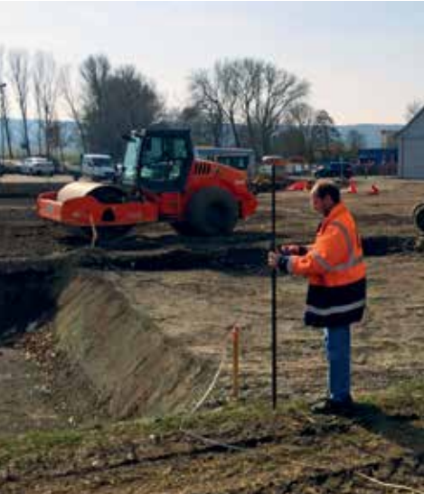
Abstecken von Punkten und Achsen im Tiefbau
