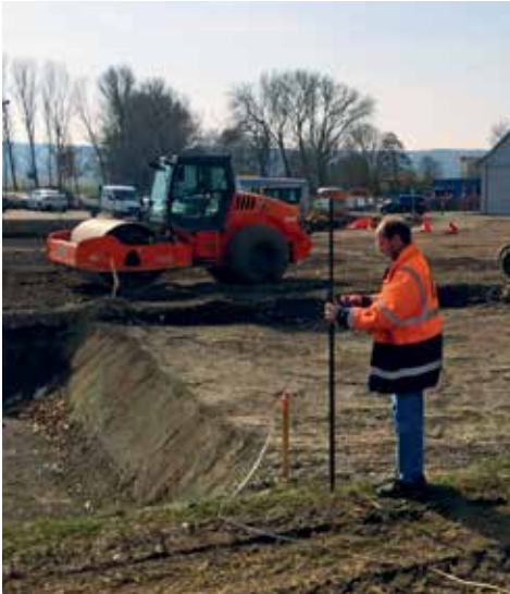
Abstecken von Punkten und Achsen im Tiefbau
