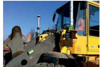
Zwei GNSS-Antennen auf dem Radlader
