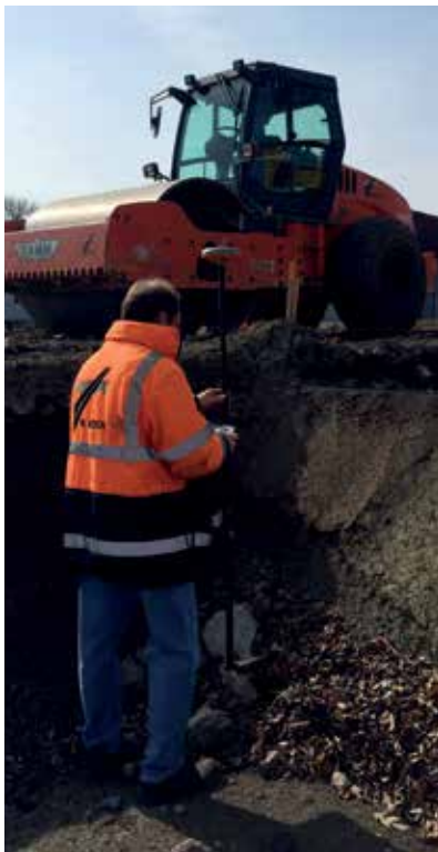
Volumenberechnung einer Baugrube
