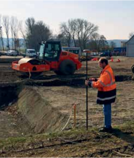
Abstecken von Punkten und Achsen im Tiefbau
