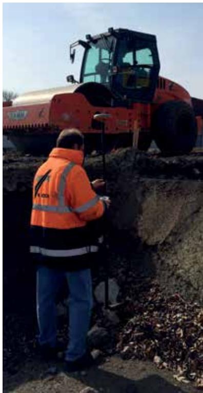
Volumenberechnung einer Baugrube
