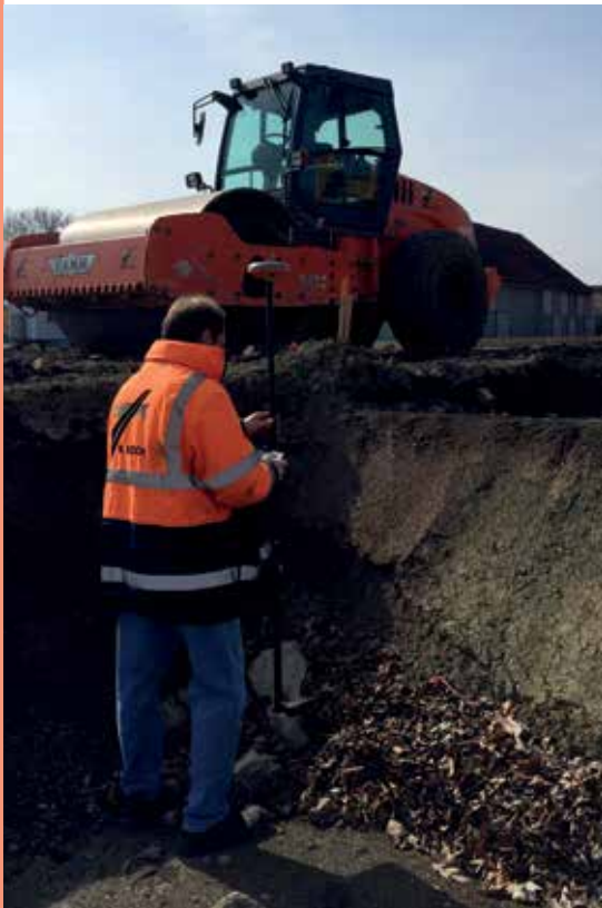
Volumenberechnung einer Baugrube
