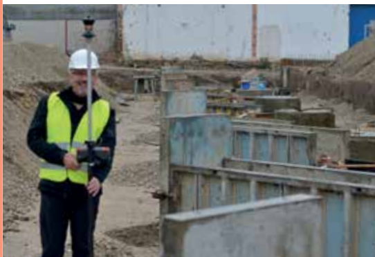
Messung mit Rundum-Prisma auf der Baustelle
