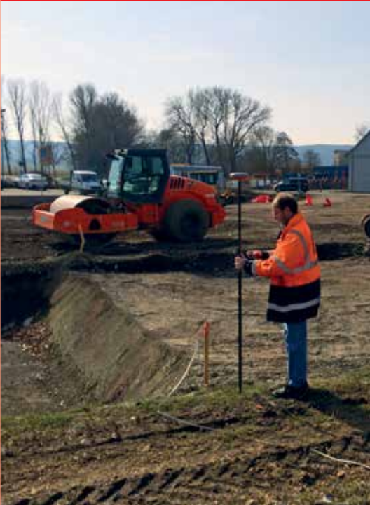
Abstecken von Punkten und Achsen im Tiefbau
