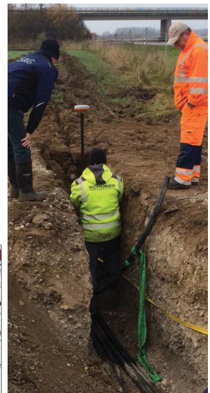
Einmessen eines Kabels im Kanalbau
