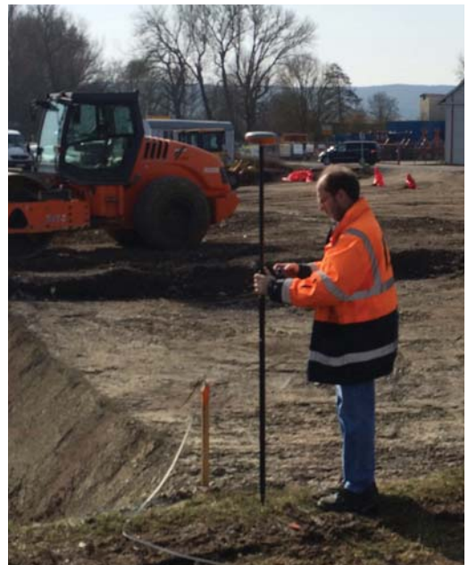
Baubabsteckung und Volumenaufnahme
